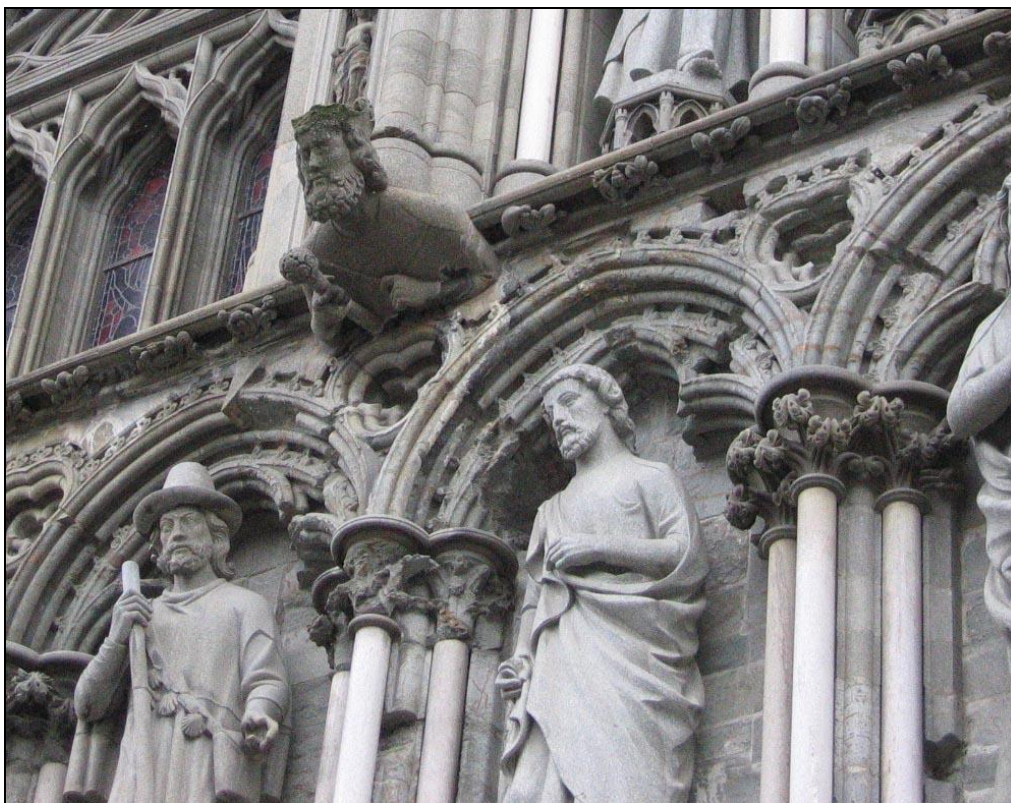
Figur 20: Steinkonstruksjoner eksponert utendørs vil gradvis forvitte. Hastigheten vil avhenge av klima og forurensningsbelastningen. Bildet viser begynnende forvitring på skulpturelementer, særlig søyledekorasjonene, på Nidarosdomens front. (Foto: Terje Grøntoft, 2004).
