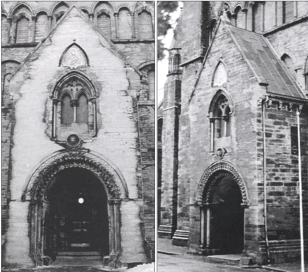
Figur 9: Værfaktorer virker ofte sammen, synergistisk, i nedbrytningen av kulturminner. Frost etter regn på steinmaterialer øker erosjonen. Bildene viser frost på vegg på Nidarosdomen. (Foto: Per Storemyr, Kilde: "The stones of Nidaros", dr. avhandling).
