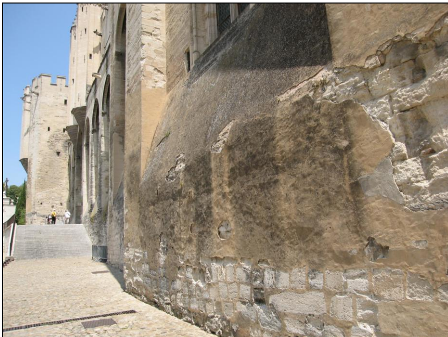
Figur 25: Portland sement har mange steder blitt brukt til istandsetting av steinbygninger. Denne sementen er stiv, hard og tett og det er stor risiko for at den vil sprekke fra steinen under ved at den beveger seg annerledes med endringer i fuktighet og temperatur og ved at den sperrer inne fuktighet. Bildene viser restaurering gjort med Portland sement på fasaden av pavepalasset i Avignon, Frankrike. (Foto: Terje Grøntoft, 2008).
