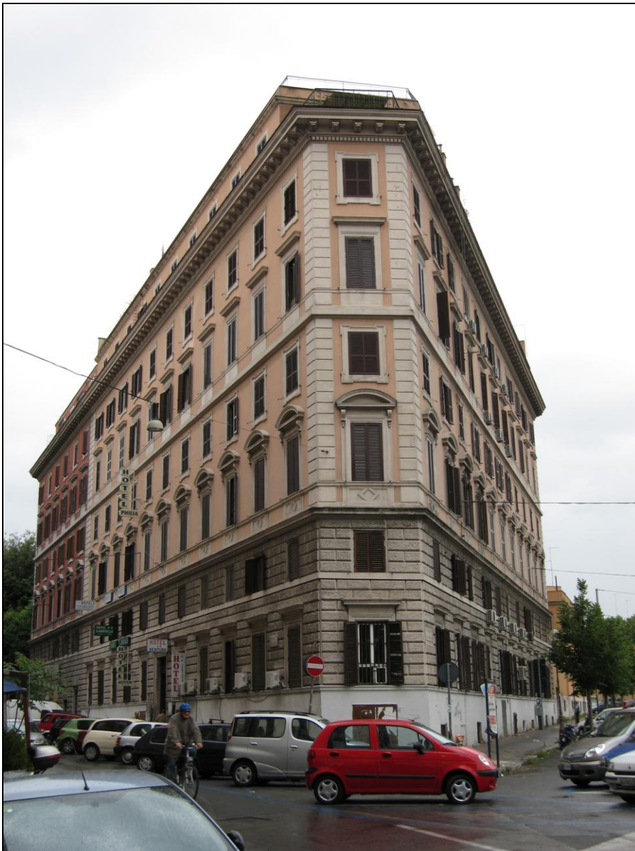
Figur 19: Smuss er estetisk uønsket og kan bidra til kjemisk og fysisk skader på bygningsoverflater. Her: Graderinger av tilsmussing på bygning langs trafikkert gate i Roma sentrum. (Foto: Terje Grøntoft, 2007).
