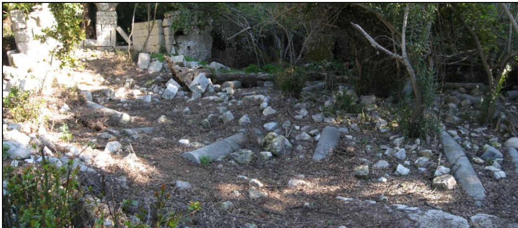
Figur 11: Jordskjelv har historisk ødelagt byer og monumenter. Bygninger vi i dag ser som ruiner i jordskjelvområder kan ha blitt delvis eller helt ødelagt ved jordskjelv. Bildet viser kirkeruin i Olympos, Tyrkia, muligens først gjort til ruin ved jordskjelv. (Foto: Terje Grøntoft, 2008).
