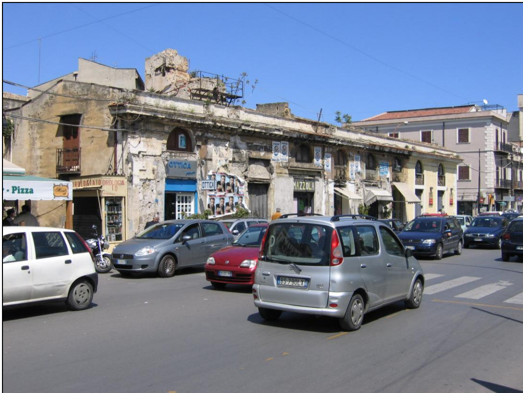
Figur 7: Luftforurensninger, f. eks, fra biltrafikk akselererer hastigheten til nedbrytende overflatereaksjoner på kulturminner utendørs og ved ventilasjon til innendørs miljø. Bildet viser gatetrafikk og delvis istandsatt bygning i Palermo, Italia. (Foto: Terje Grøntoft, 2006).
