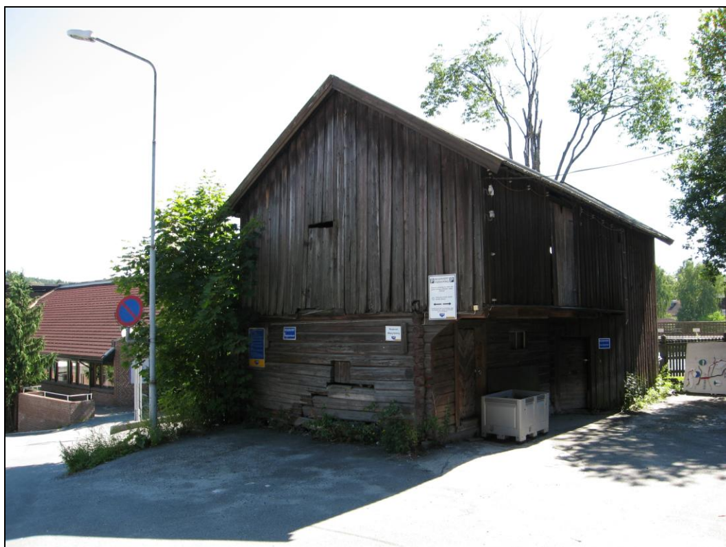
Figur 16: Ved berøring eller sammenstøt mellom kjøretøyer og kulturminner kan skader med forskjellig alvorlighetsgrad oppstå. De fleste skader vil i utgangspunktet være av mindre omfang. På bildet sees reparerte skader på et eldre uthus i tre i Kongsberg sentrum, muligens etter påkjørsel av bil. (Foto: Terje Grøntoft, 2008).
