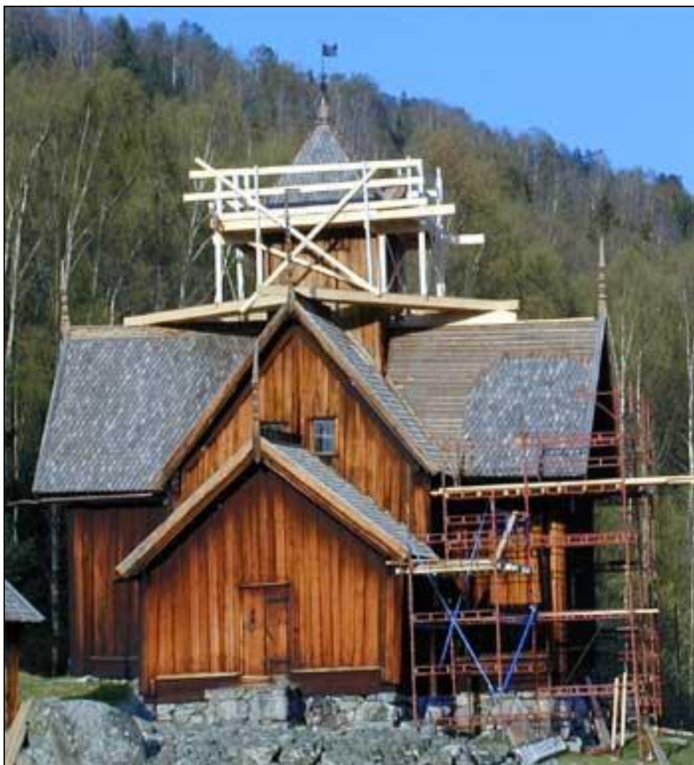
Figur 28: Regelmessig vedlikehold av kulturminner og miljøer kreves for å bevare dem på et akseptabelt "ytelsesnivå" som f.eks. beskrevet i Norsk Standard NS 3452. Vedlikehold er, særlig for større kulturarvbygninger, en kontinuerlig prosess. Bildet viser ytre vedlikehold på Uvdal stavkirke, våren 2004. (Kilde: http://www.numedal.net/ ).
