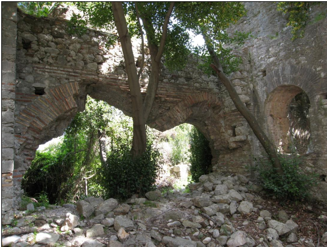
Figur 17: Mekaniske sammenbrudd er typisk forårsaket av en eller annen fysisk skade. Bildet viser et sannsynlig snart forestående mekanisk sammenbrudd for en vegg i ruinen av det romerske badet i Olympos, Tyrkia. (Foto: Terje Grøntoft, 2008).
