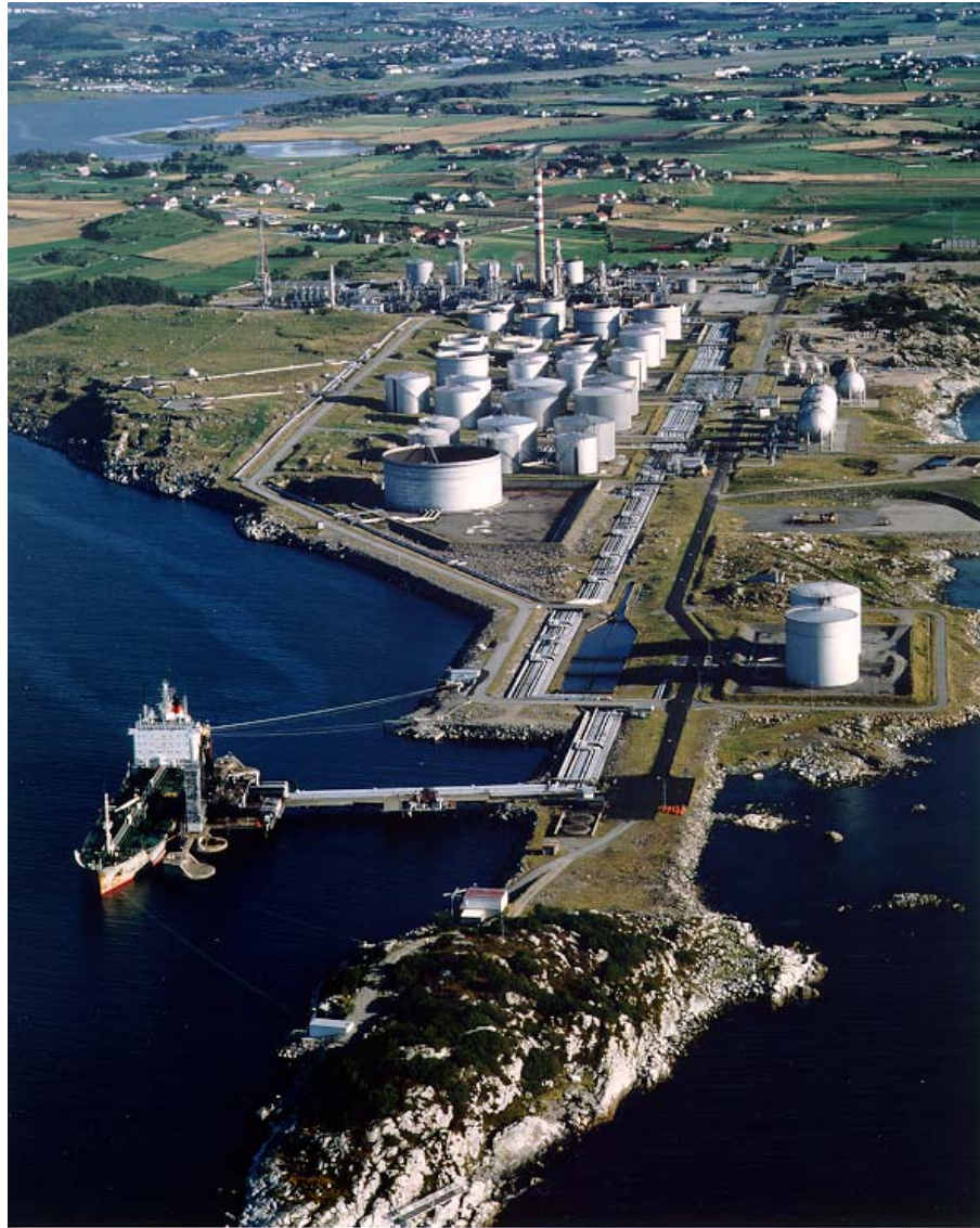
Figur 1: Luftfoto av raffineriet sett fra nordvest. Nærmest er utskipingshavn, dernest tankfarm og lengst bort selve raffineridelen. Legg merke til skorsteinen (90 m, rød og hvitstripete) og flammestårn (60m, mot venstre). I bakgrunnen er spredt bebyggelse. Foto fra Norske Shell A/S.
